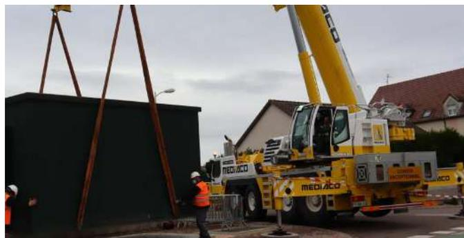
L'entreprise Altitude infrastructure, chargée du déploiement de la fibre optique dans notre département est intervenue en octobre pour poser un « shelter technique » de 21 tonnes et destiné à abriter le nœud de raccordement optique qui desservira notre commune pour la fibre à la maison mais aussi les communes de Rouvres en Plaine, Longecourt en Plaine et Bretenière.
